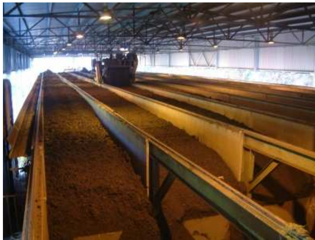
Слика 6.7. Пример постројења за компостирање
